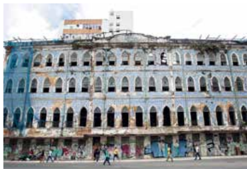
Casarões abandonados correm risco de desabar
